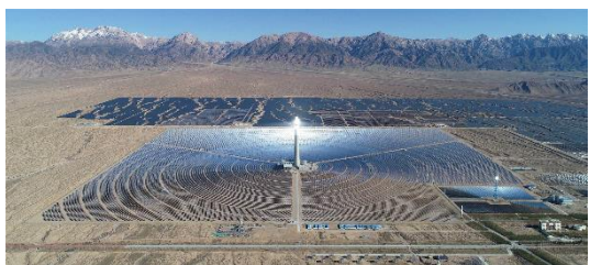
中控太阳能德令哈 50MW 塔式热发电系统
